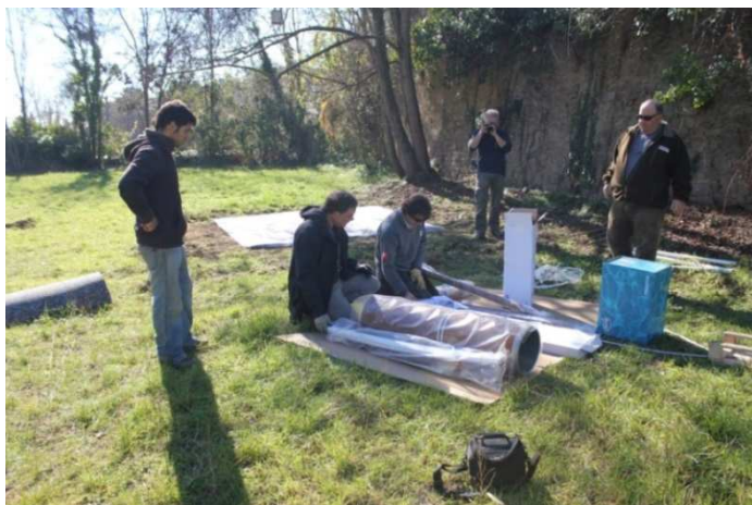
Instal·lat l'aïllant a la base a on s'instal·larà el recipient, i passos previs al muntatge.
