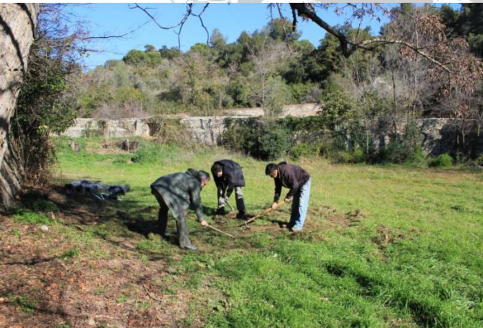
Primers treballs d'arranjament del terreny.
